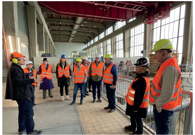
Exkursion und Führung durch den Kraftwerkspark Simmering (Foto: J. Pachschwöll)
