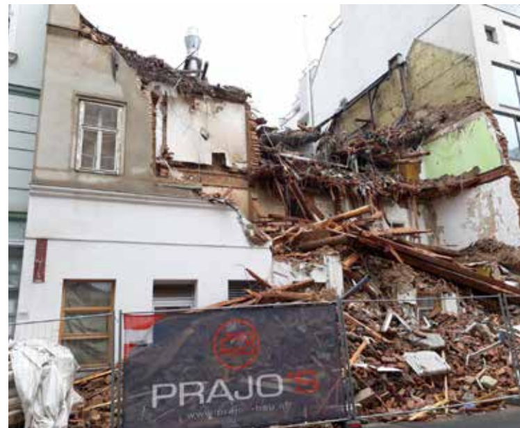
Gründerzeithaus im Abriss kurz vor Novellierung der Wiener Bauordnung (Foto: E. Gruber, Mai 2019)
