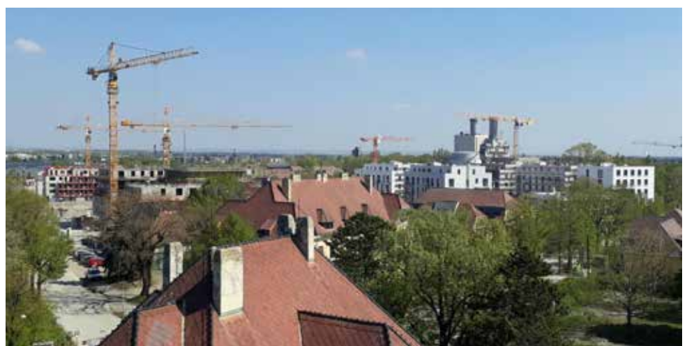
Stadterweiterung im alten Gaswerk in Neu-Leopoldau (Foto: E. Gruber, April 2019)
