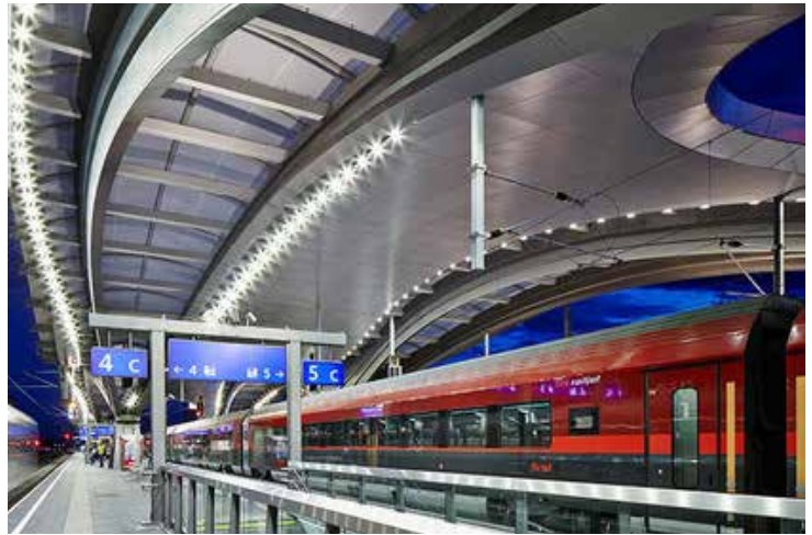
Graz Hauptbahnhof (Quelle: Philips)
