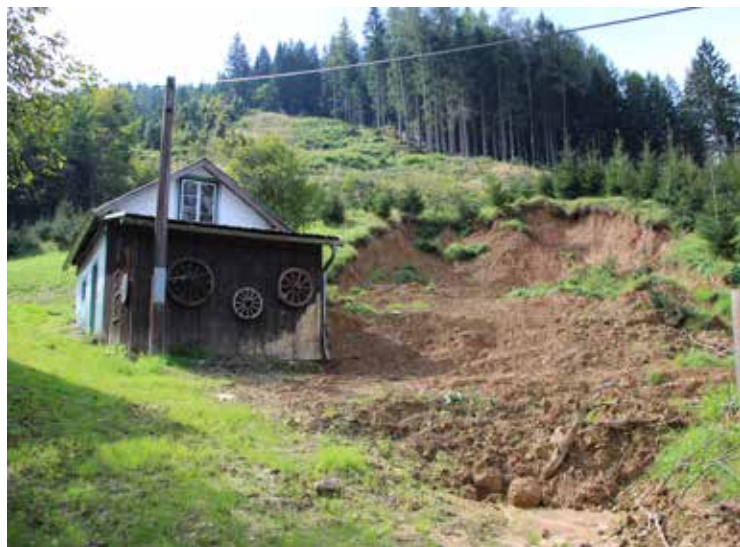
Rutschung nahe Annaberg nach dem Starkniederschlagsereignis im Mai 2014 (Foto: K. Gokesch)
