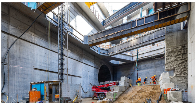
Blick in die U-Bahn-Baustelle U2-U5 (Foto: Wiener Linien, © Simon Wöhler)
