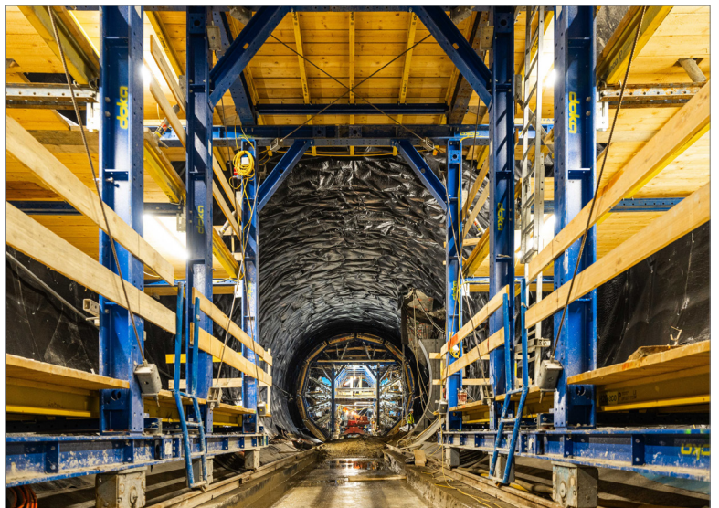
Tunnelbau im Bereich der U2neu (Foto: Wiener Linien, © Simon Wöhler)
